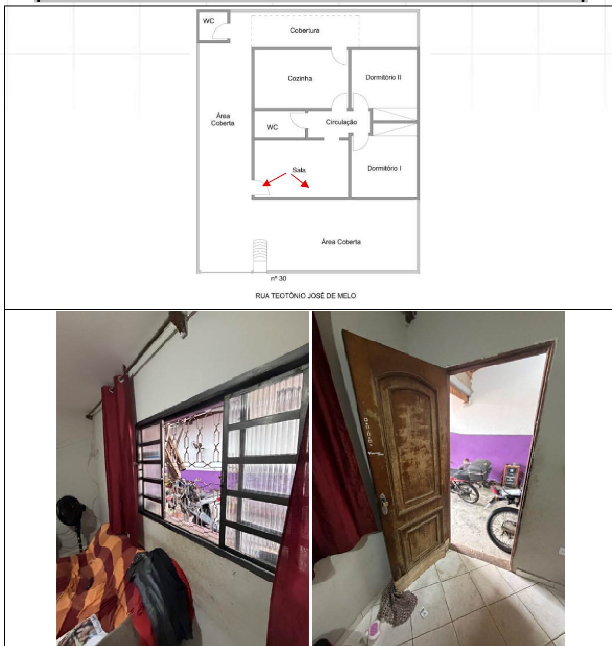
DETALHE DA PORTA E JANELA DA SALA.
