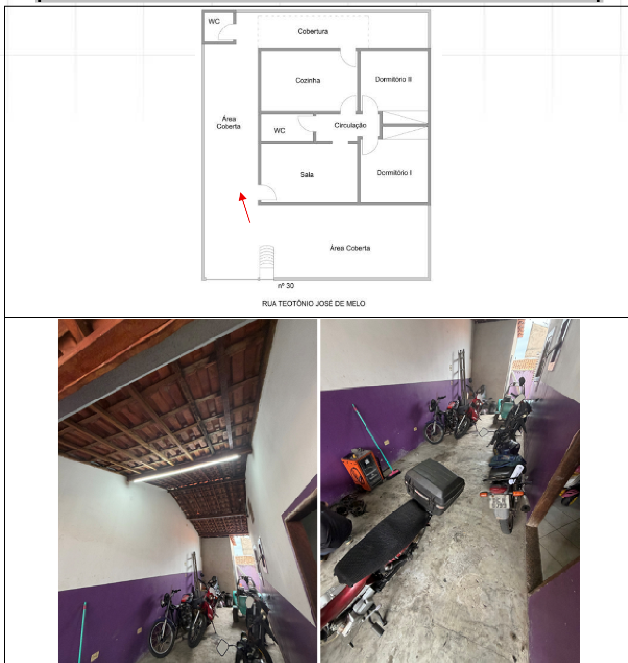
DETALHE DA COBERTURA E PISO DO RECUO LATERAL.
