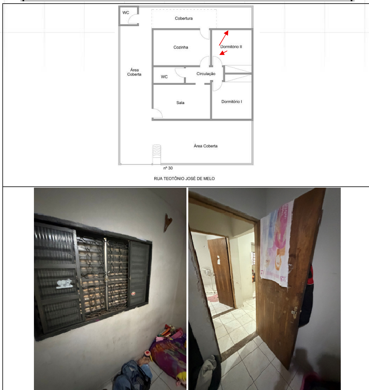
DETALHE DA JANELA E PORTA DO DORMITÓRIO II.
