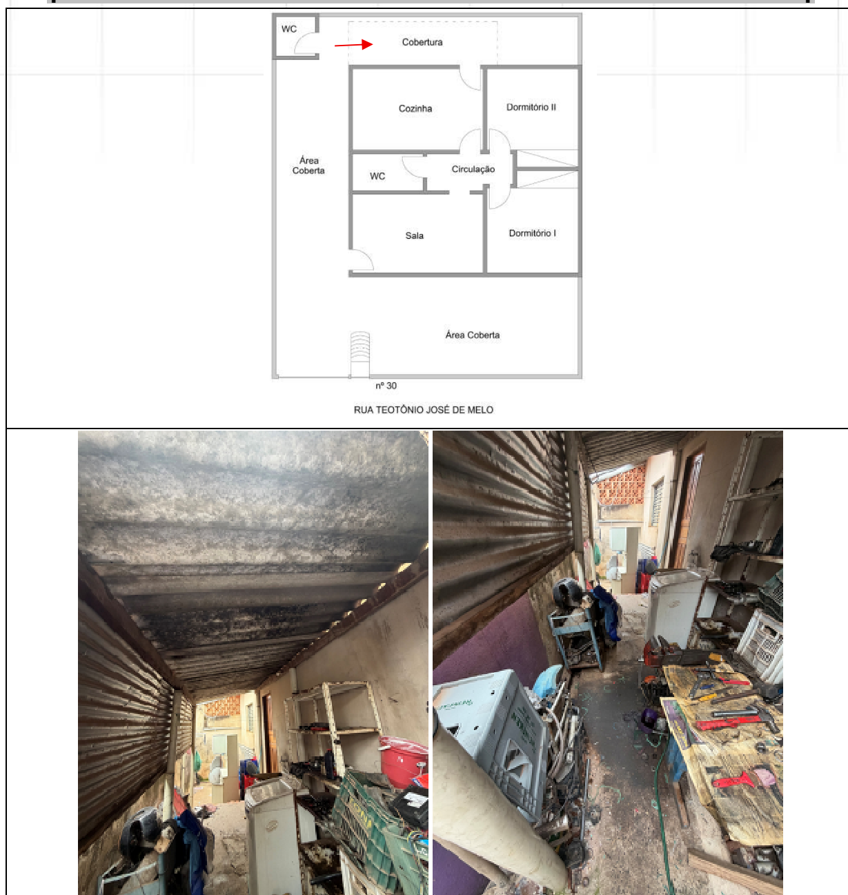
DETALHE DA COBERTURA E PISO DO RECUO DOS FUNDOS.
