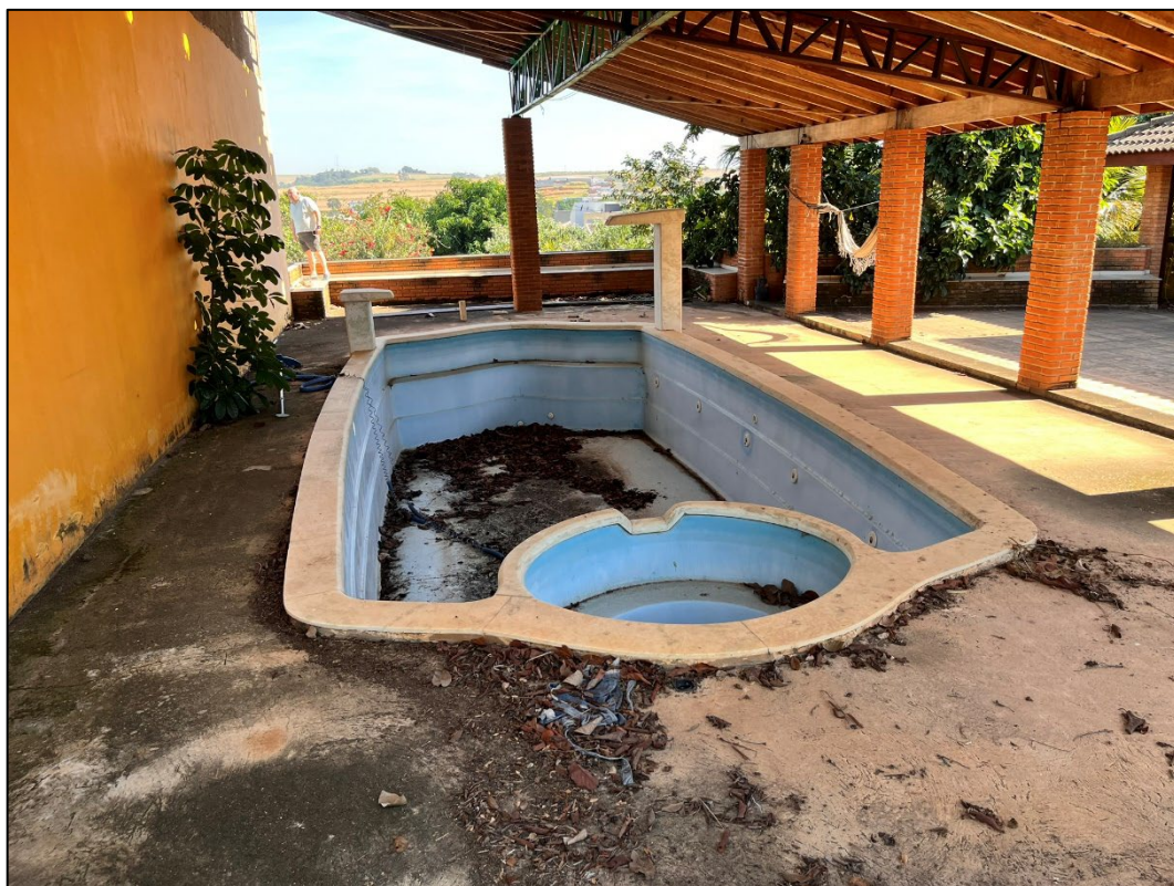
Figura 16 - Vista geral externa
