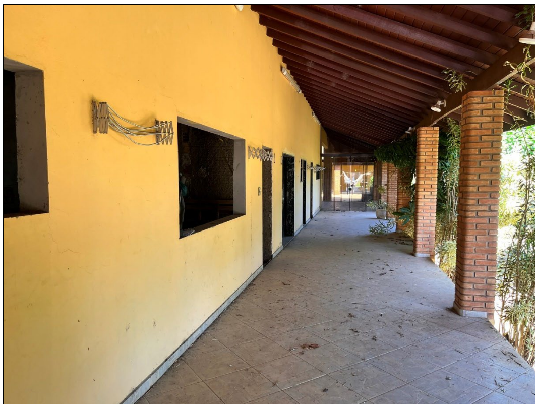
Figura 14 - Vista geral externa
