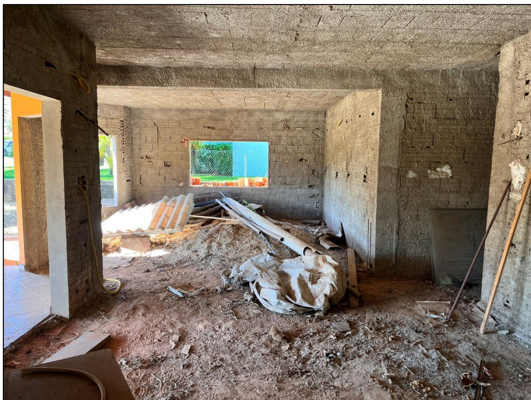
Figura 18 - Vista geral interna
