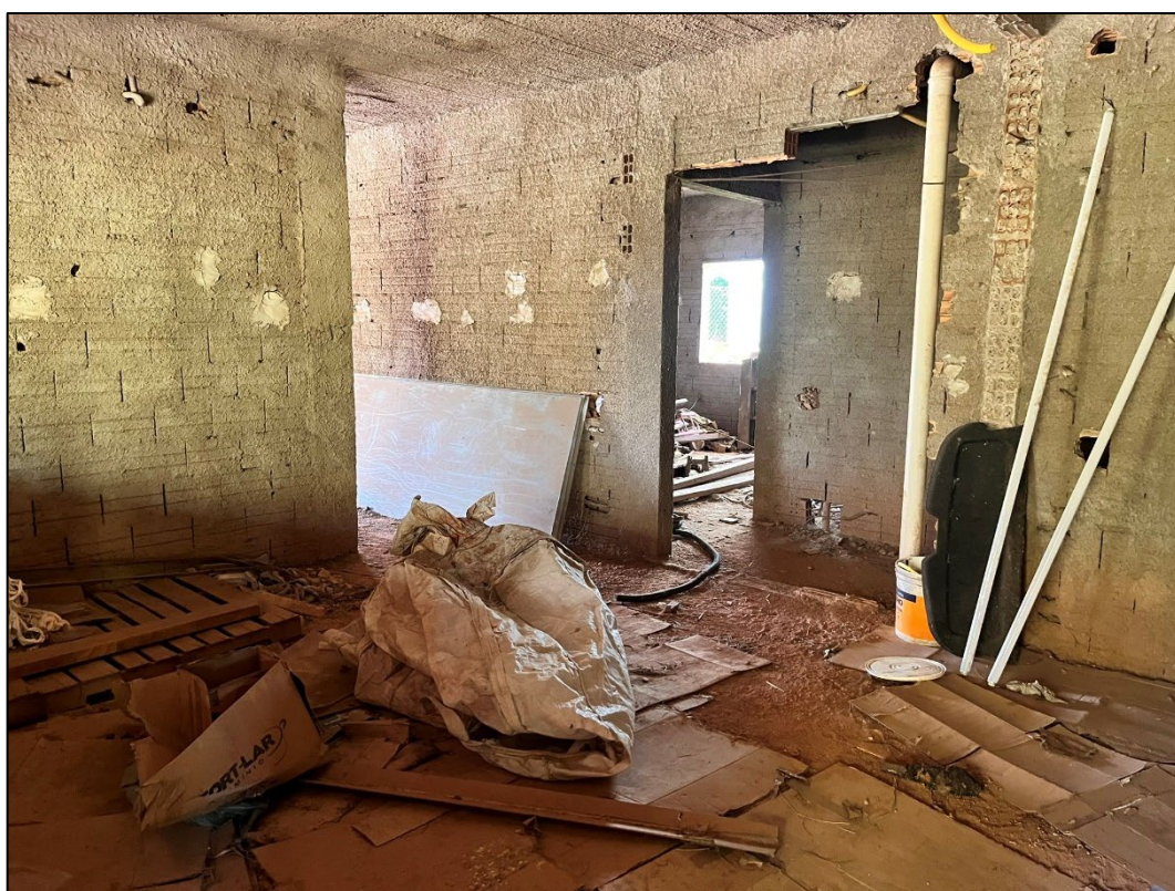
Figura 19 - Vista geral interna
