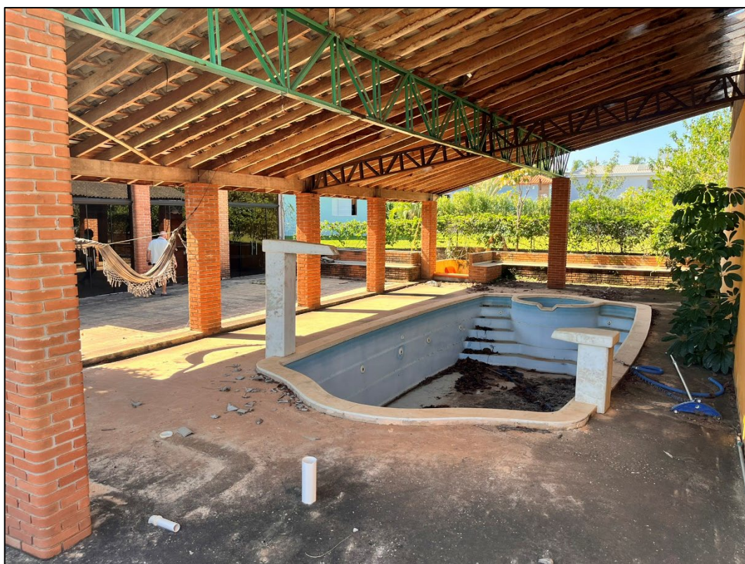
Figura 17 - Vista geral externa
