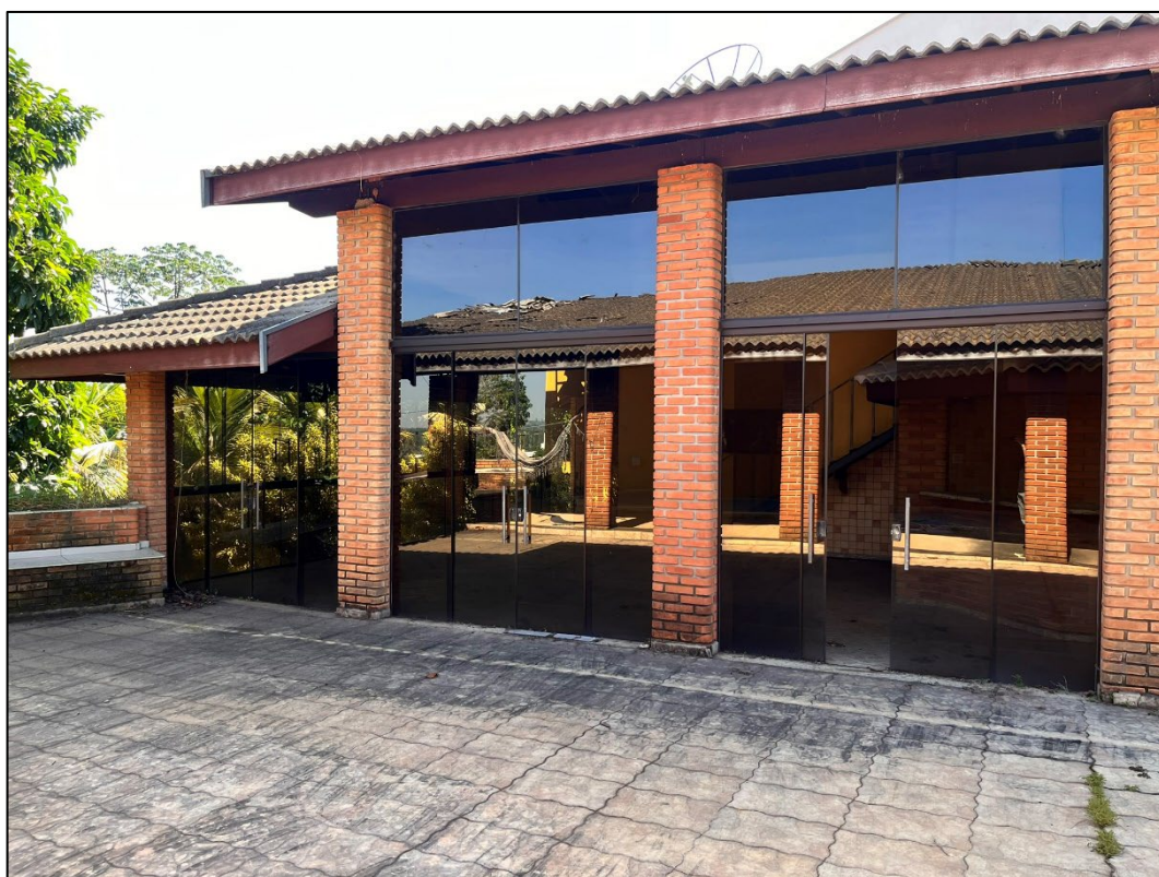
Figura 15 - Vista geral externa
