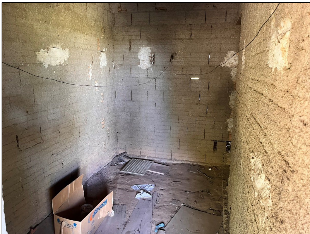
Figura 22 - Vista geral interna
