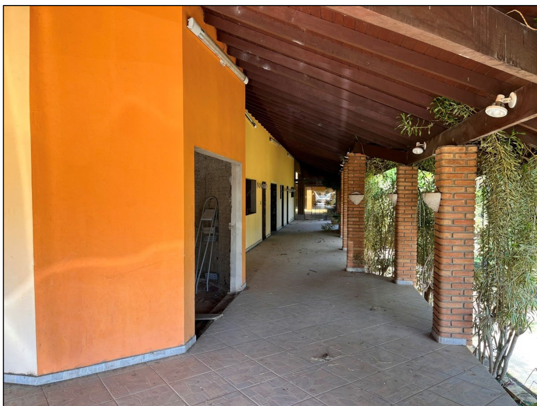
Figura 13 - Vista geral externa
