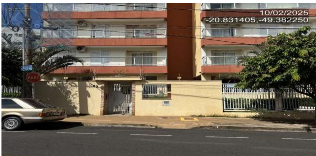
Figura 9 –Entrada do condomínio
