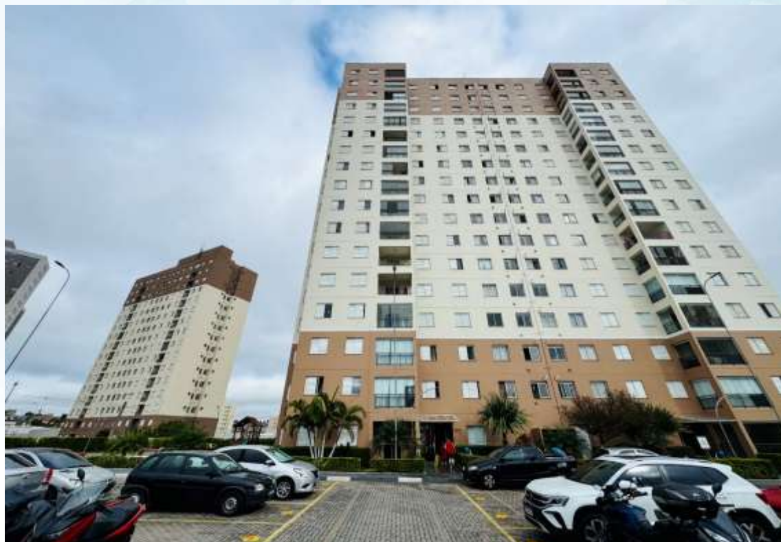
Fachada do condomínio / bloco 1 (2)
