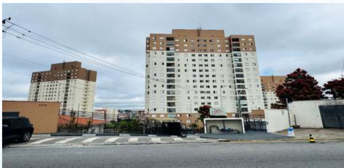
Fachada do condomínio / bloco 1 (1)
