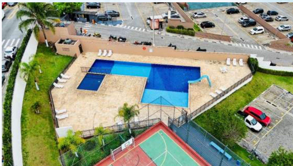
Piscina – Foto feita com drone
