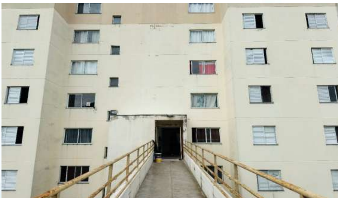
Fachada torre 10 (torre do imóvel executado) – Condomínio Residencial Violetas
