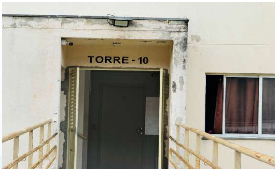
Fachada torre 10 (torre do imóvel executado) – Condomínio Residencial Violetas
