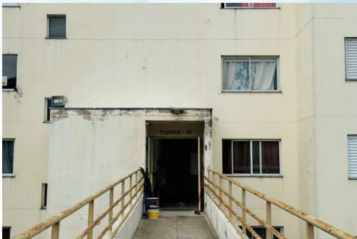
Fachada torre 10 (torre do imóvel executado) – Condomínio Residencial Violetas
