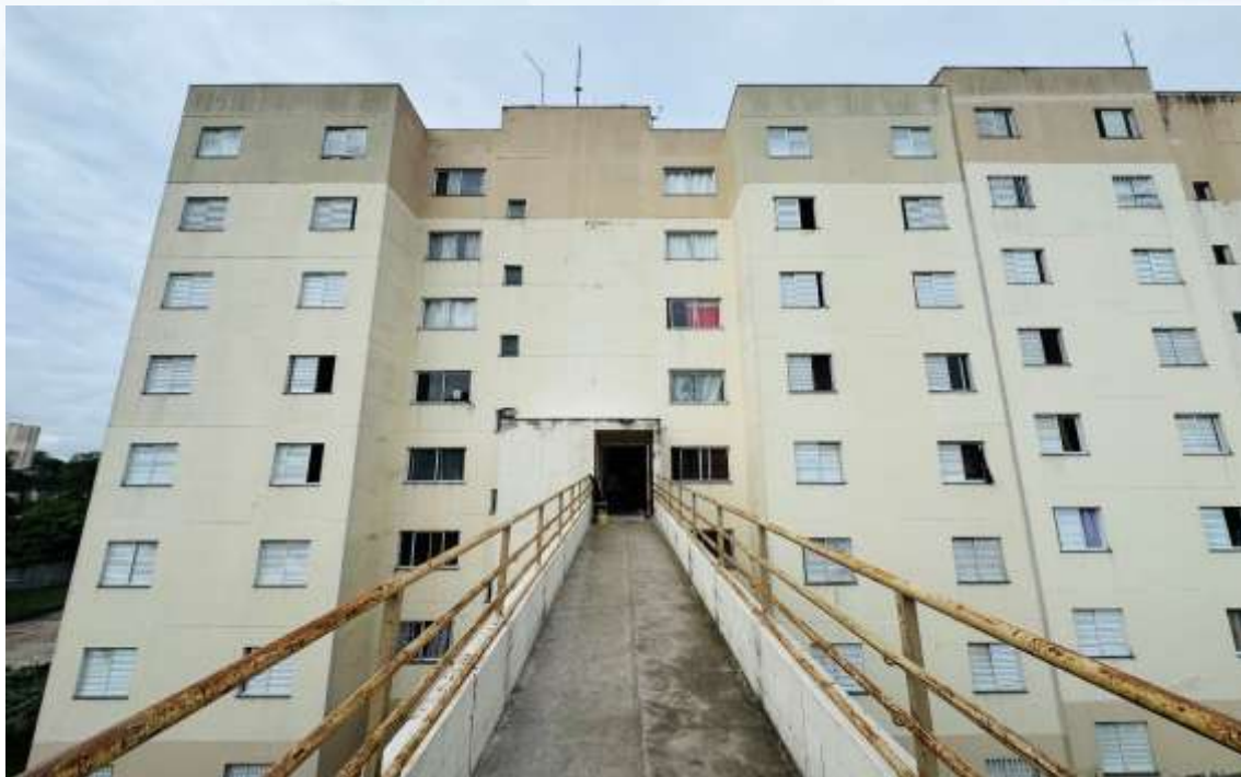
Fachada torre 10 (torre do imóvel executado) – Condomínio Residencial Violetas
