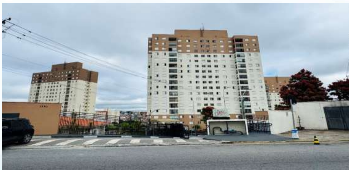
Fachada do condomínio / bloco 1 (1)
