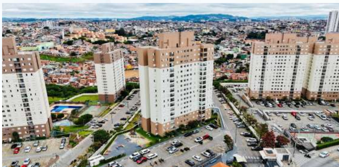
Fachada do condomínio / bloco 1 – Foto realizada com drone
