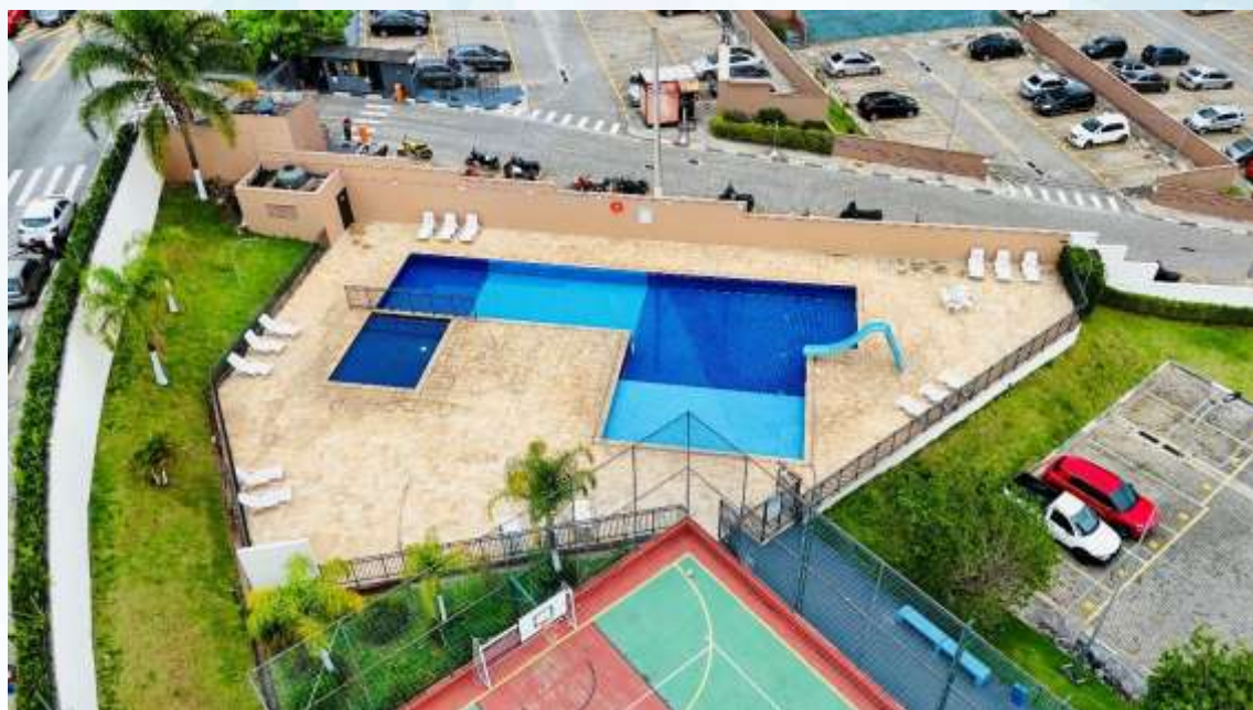
Piscina – Foto feita com drone
