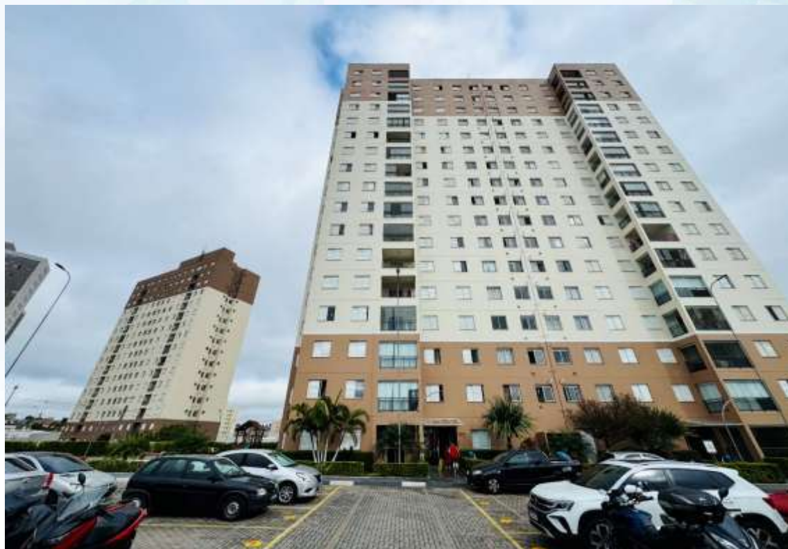
Fachada do condomínio / bloco 1 (2)
