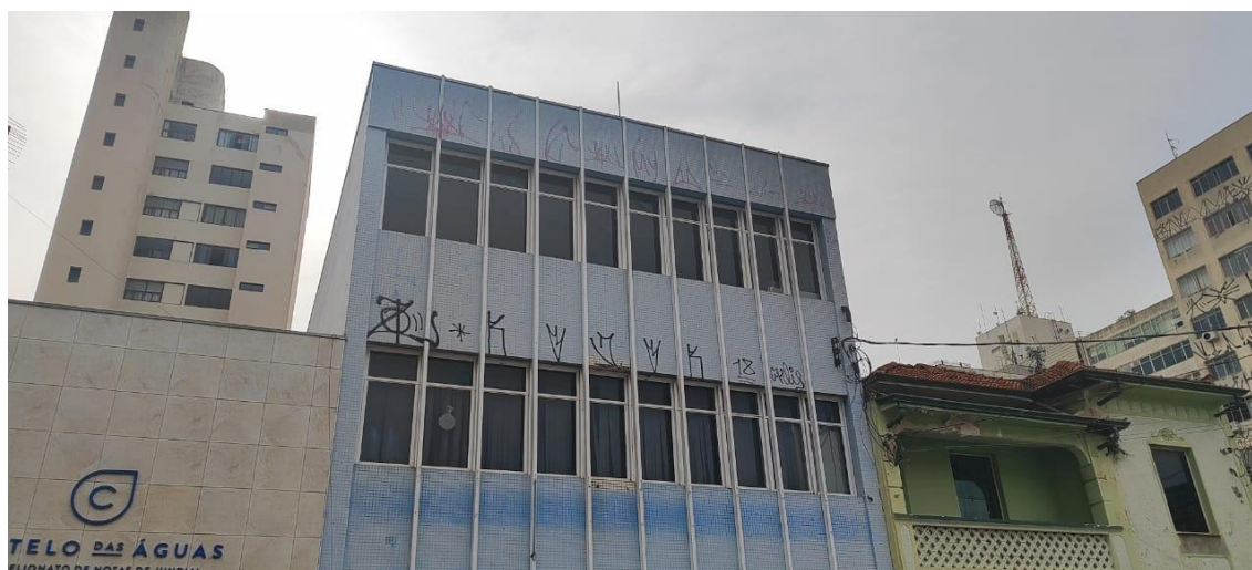
Figura 2.3 – Fachada externa da loja - 2 Fonte: A signatária
