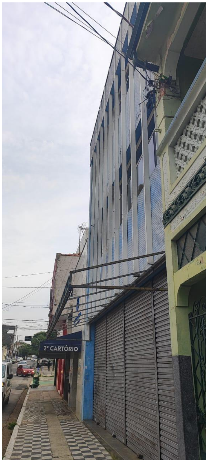
Figura 2.4 – Fachada externa da loja - 3 Fonte: A signatária
