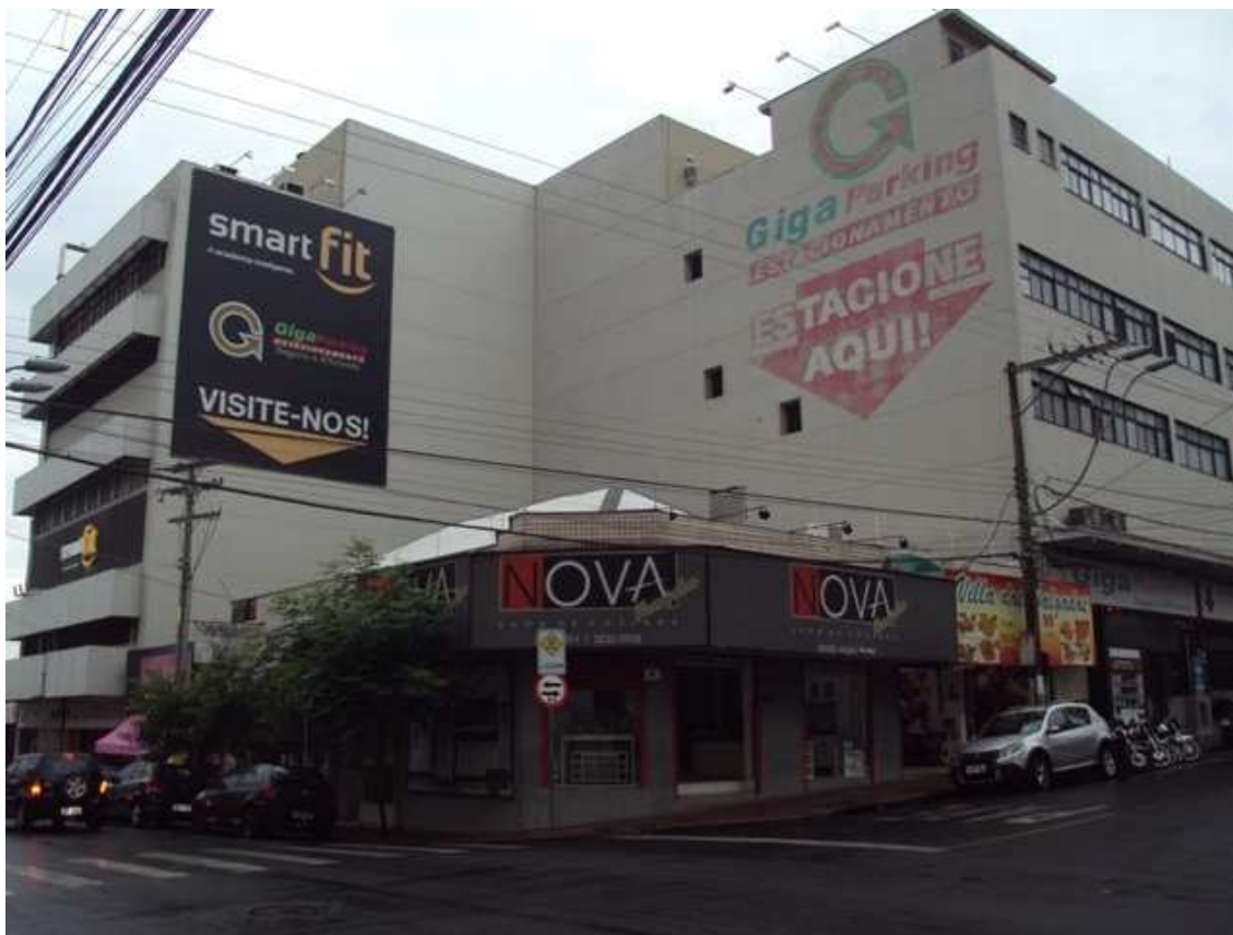
FOTO 07 – Vista do prédio pela esquina das Ruas Siqueira Campos com Coronel Spínola de Castro.
