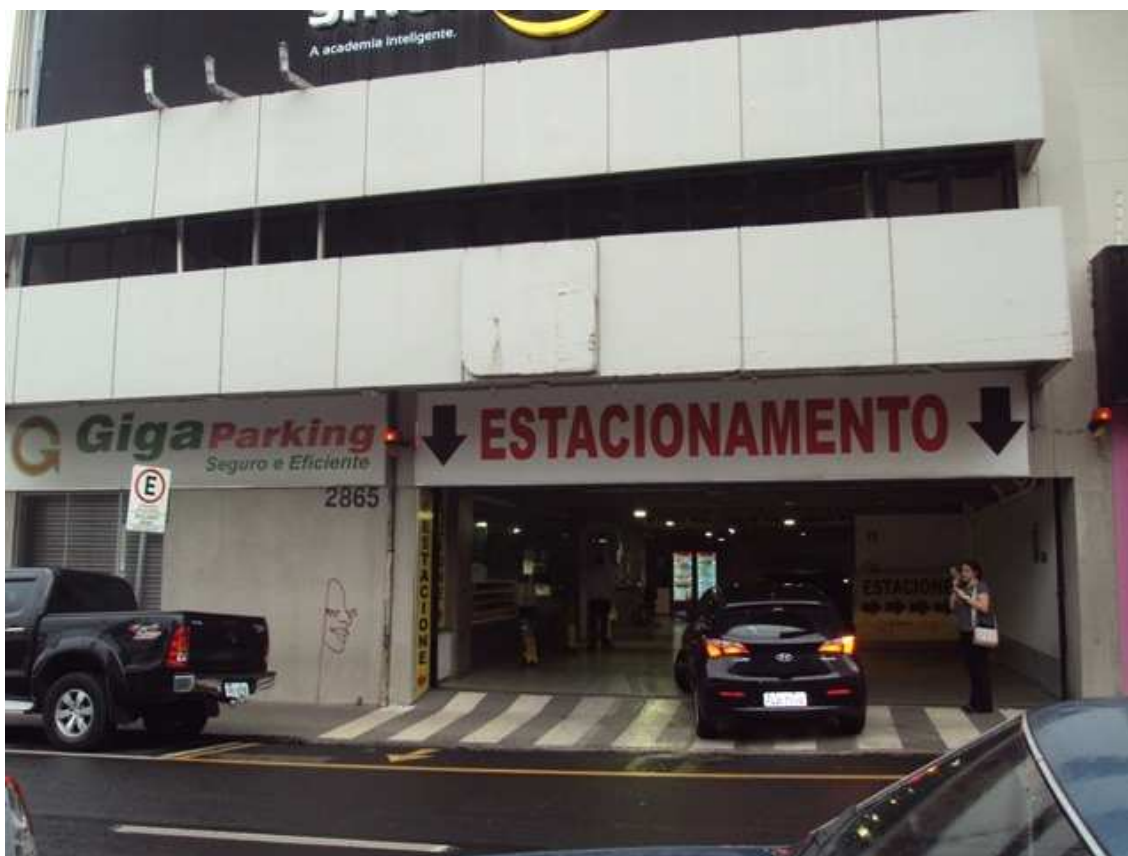
FOTO 08 – Vista da entrada do pavimento inferior pela Rua Coronel Spínola de Castro utilizado pelo Giga Parking Estacionamento.
