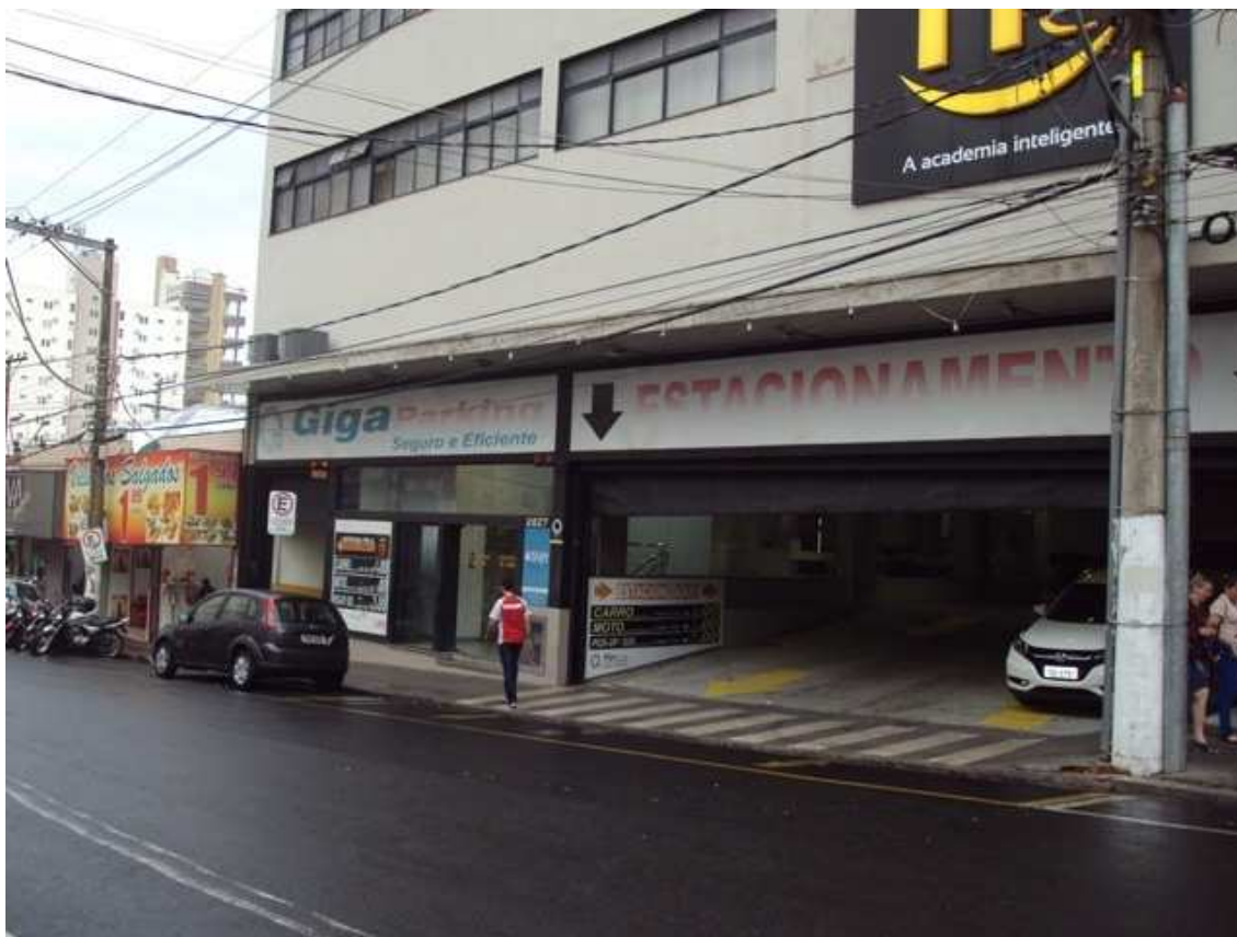
FOTO 06 – Prédio com pavimento inferior, pavimento térreo, três pavimentos e cobertura.
