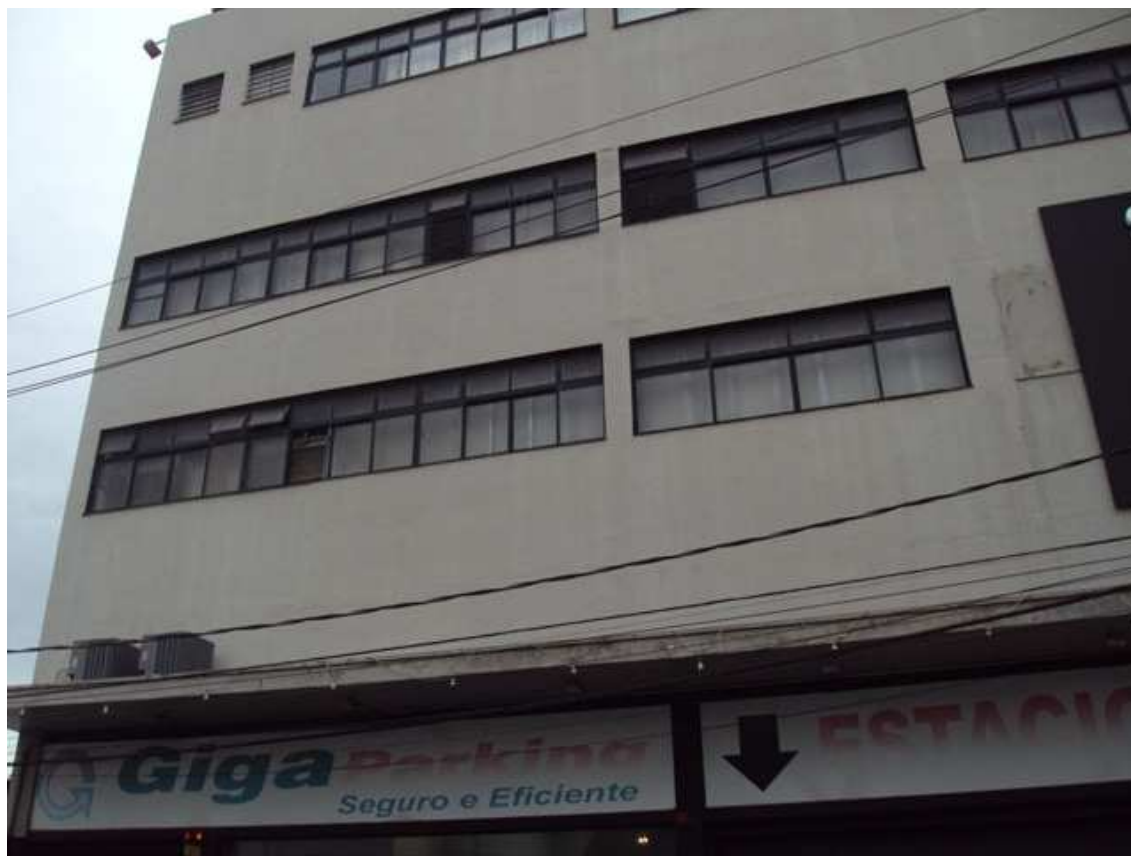
FOTO 04 – Vista do prédio com frente para a Rua Siqueira Campos.
