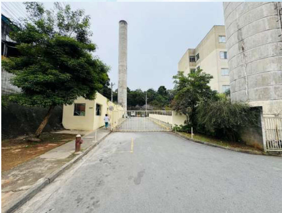
Portaria do condomínio (4)
