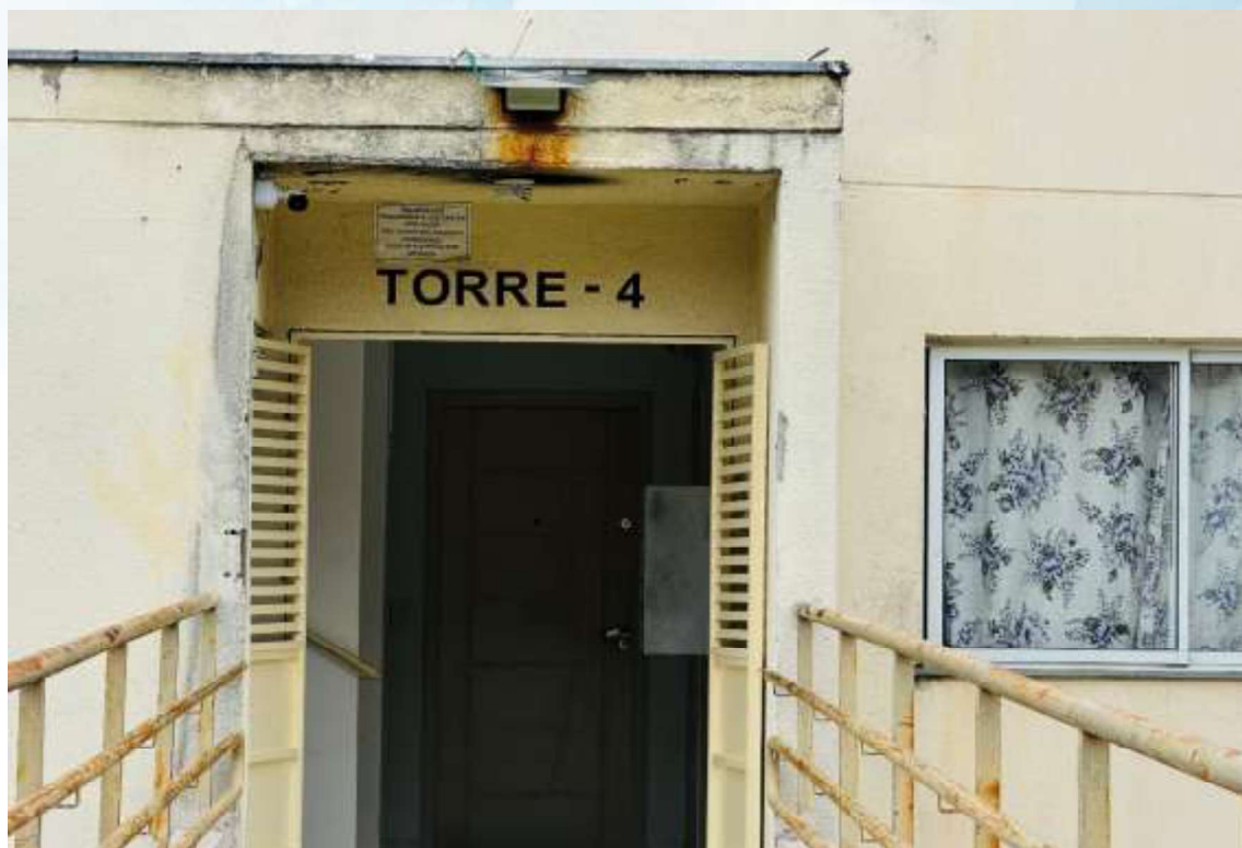
Fachada torre 4 (torre do imóvel executado) – Condomínio Residencial Violetas (3)
