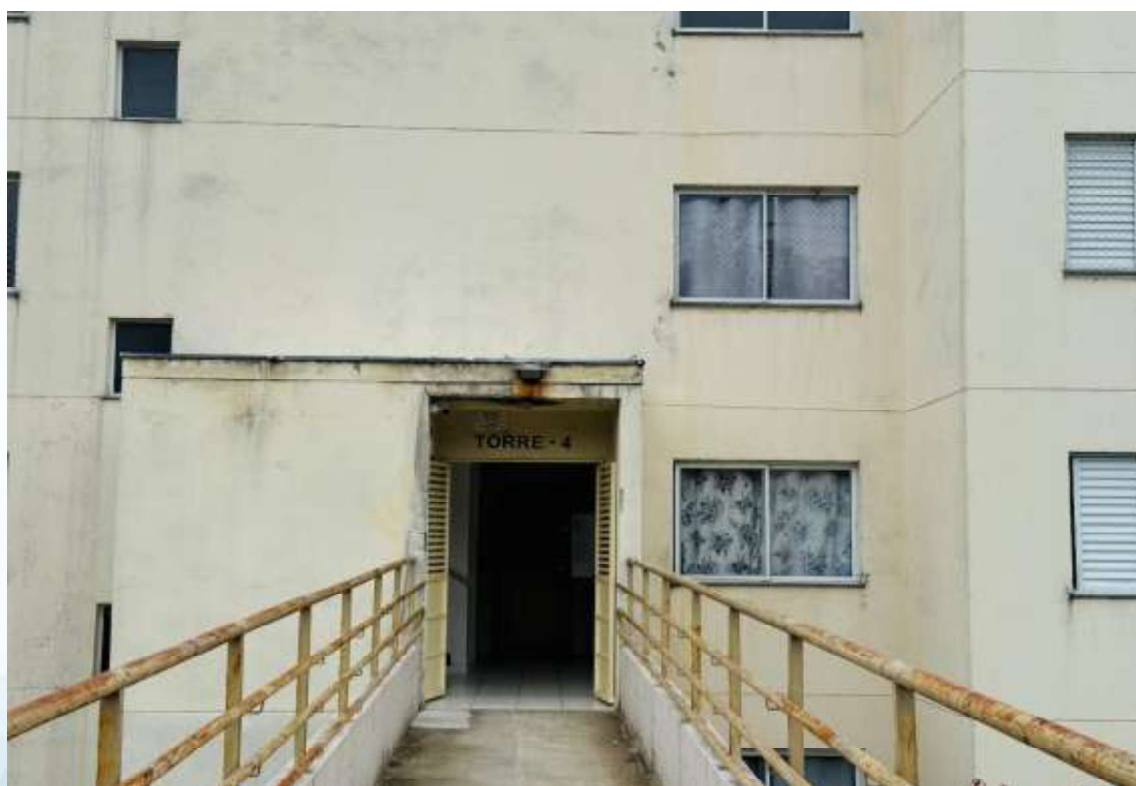
Fachada torre 4 (torre do imóvel executado) – Condomínio Residencial Violetas (2)
