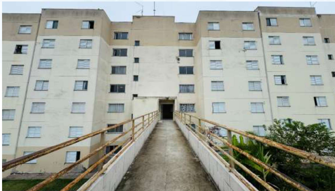
Fachada torre 4 (torre do imóvel executado) – Condomínio Residencial Violetas (1)
