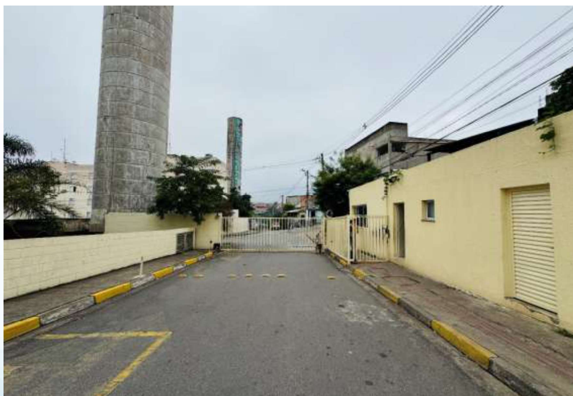
Portaria do condomínio (1)
