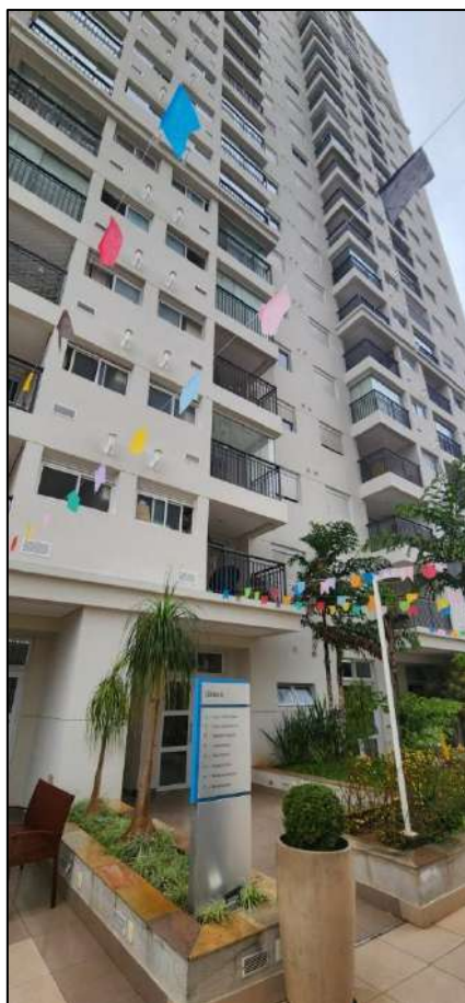
Foto 27 – Fachada da torre
