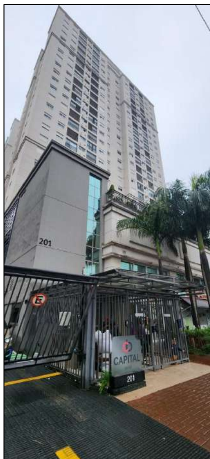
Foto 28 – Entrada do Condomínio
