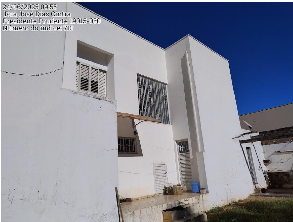
Fotos 18 – Lateral direita do imóvel com acesso à cozinha.
