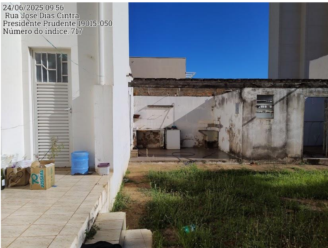
Fotos 20 – Fundo do imóvel
