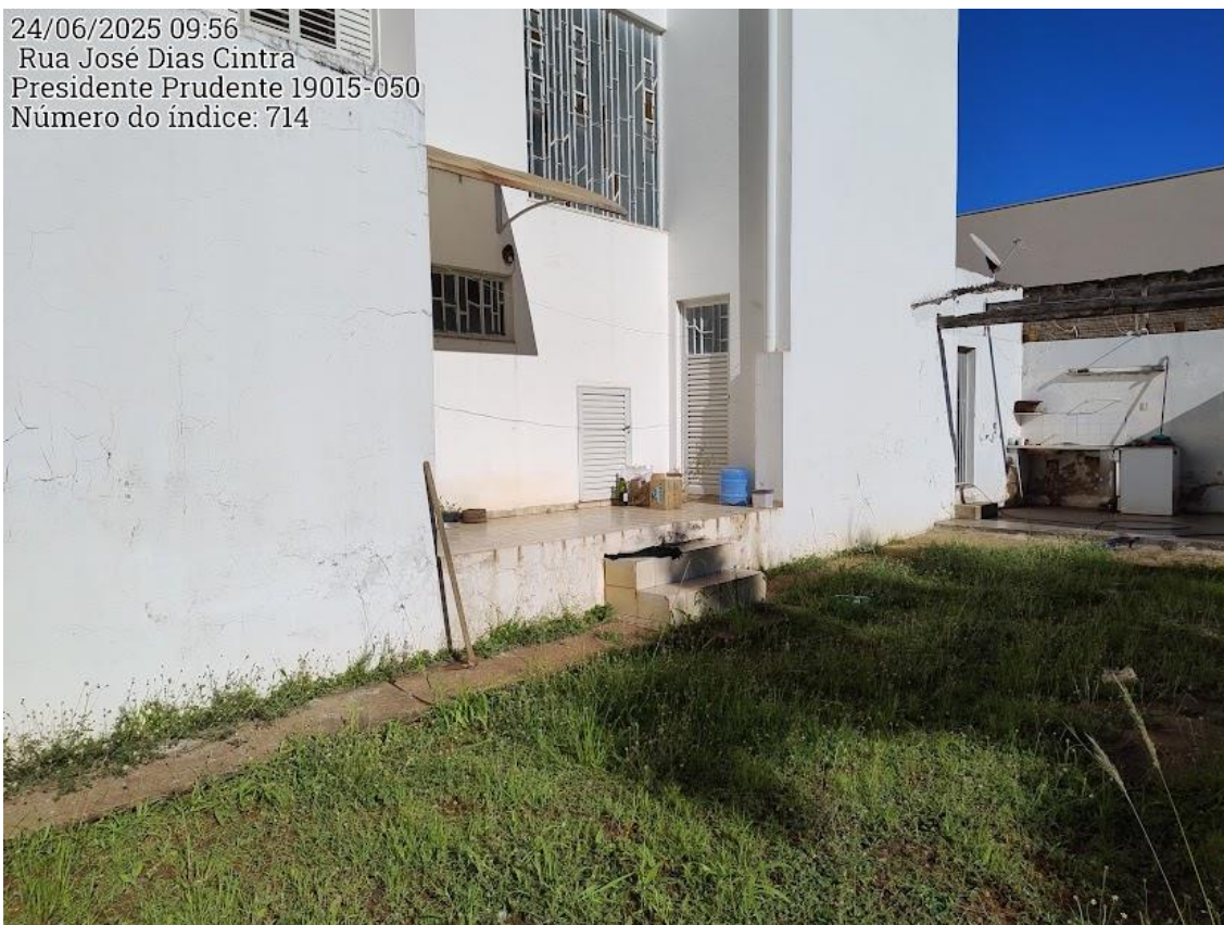
Fotos 19 – Lateral direita do imóvel com acesso à cozinha.
