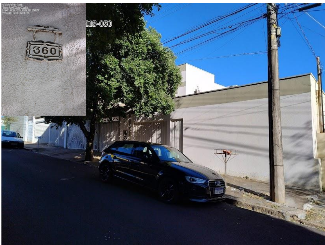
Foto 04 – Fachada e número do imóvel
