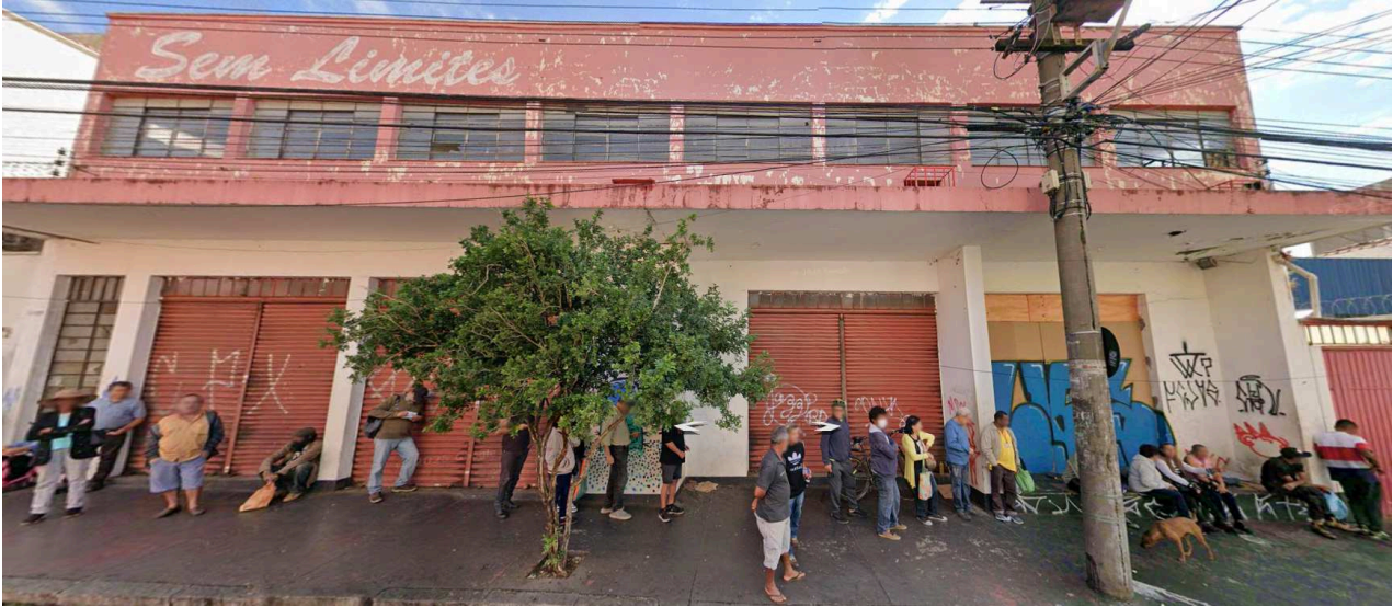
Figura 2 — Fachada frontal reproduzida do modelo anexado. A imagem apresenta pintura desgastada, portas fechadas e grafites.
