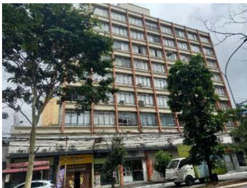
FOTO 01: Vista do imóvel
