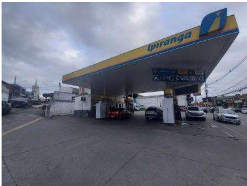
FOTO 30: Vista do imóvel
