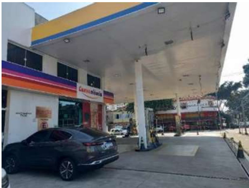
FOTO 40: Vista do imóvel
