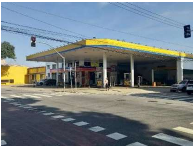
FOTO 48: Vista do imóvel
