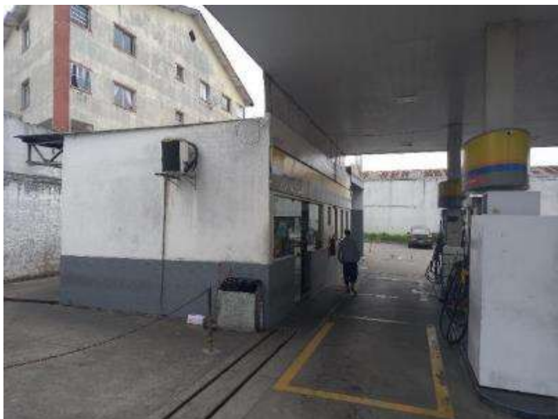
FOTO 32: Vista do imóvel
