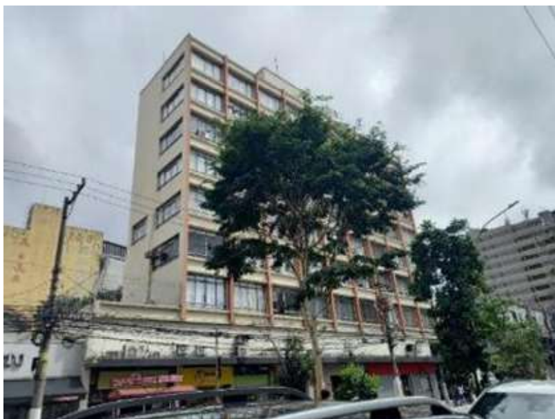
FOTO 10: Vista do prédio de número 517 na R. Pedroso de Moraes
