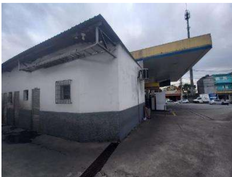
FOTO 29: Vista do imóvel
