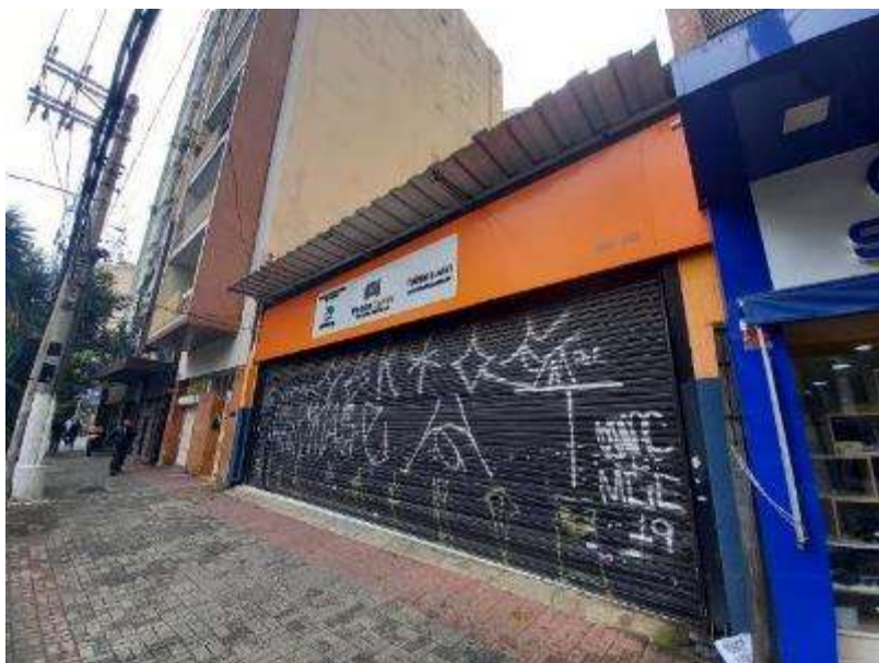
FOTO 11: Vista frontal do imóvel localizado na R. Pedroso do Moraes, n. 590
