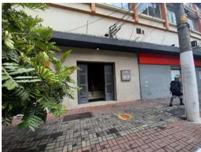
FOTO 02: Vista do acesso ao imóvel
