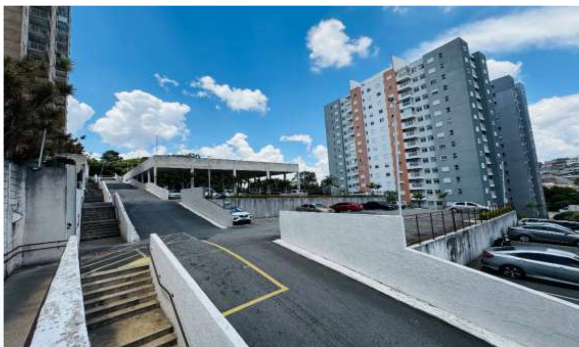
Estacionamento do condomínio (3)
