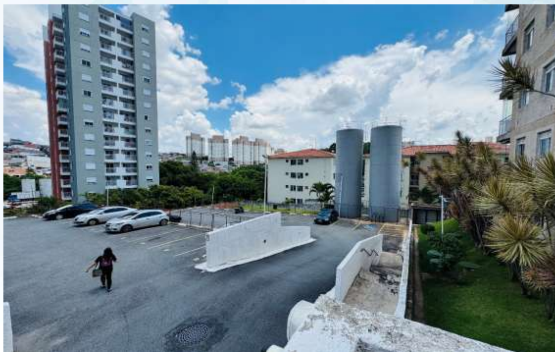
Estacionamento do condomínio (2)
