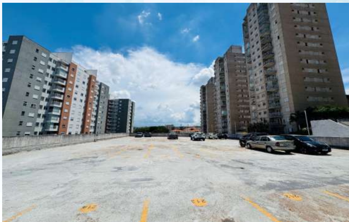
Estacionamento do condomínio (8)
