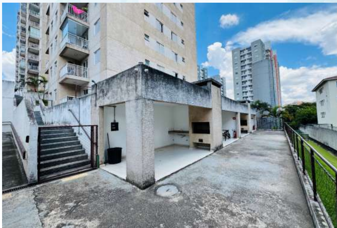
Área gourmet – área de lazer do condomínio (8)
