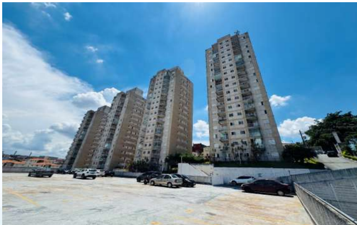
Estacionamento do condomínio (7)
