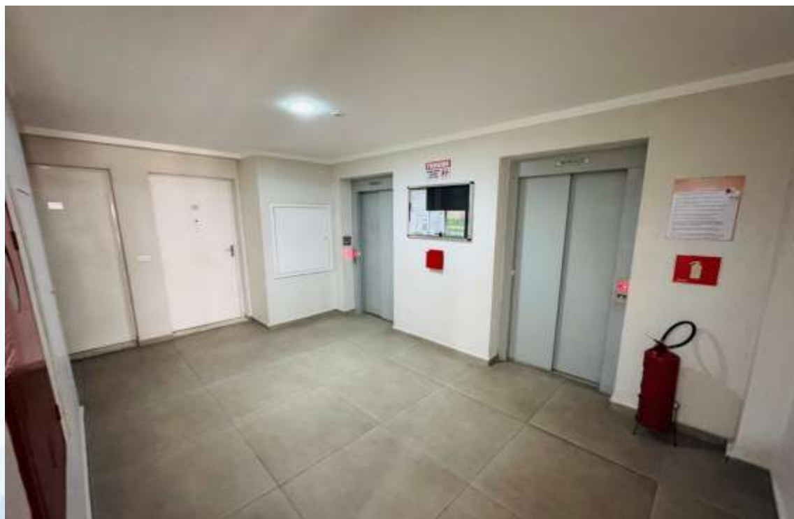
Hall de entrada da torre (2)
