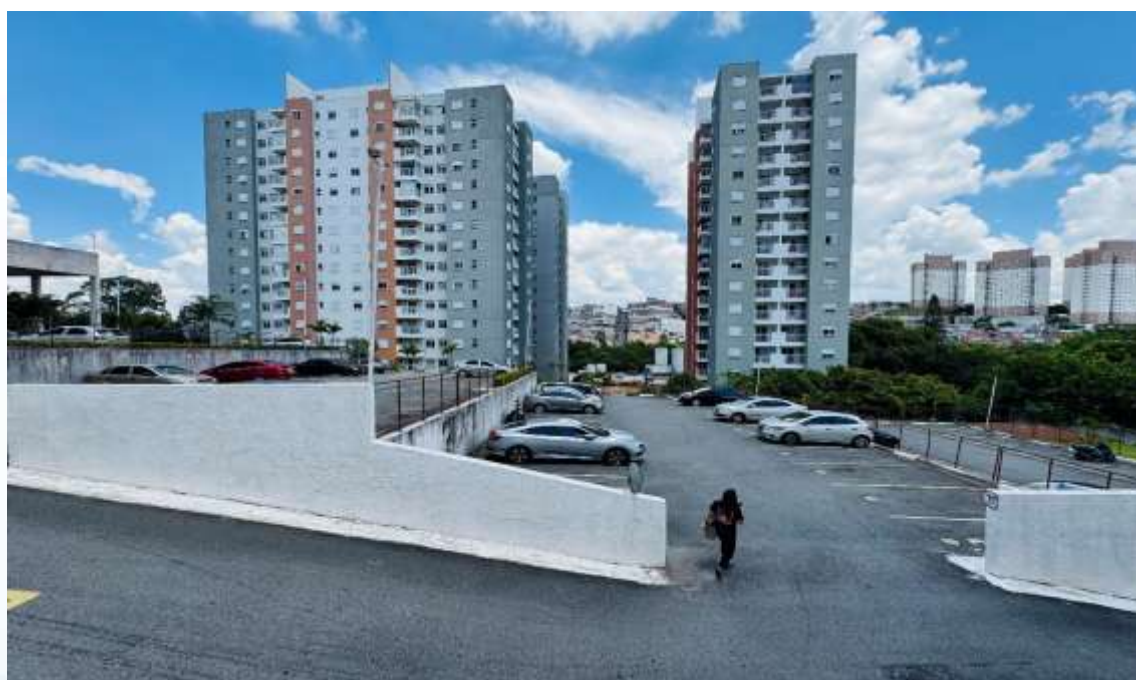
Estacionamento do condomínio (1)
