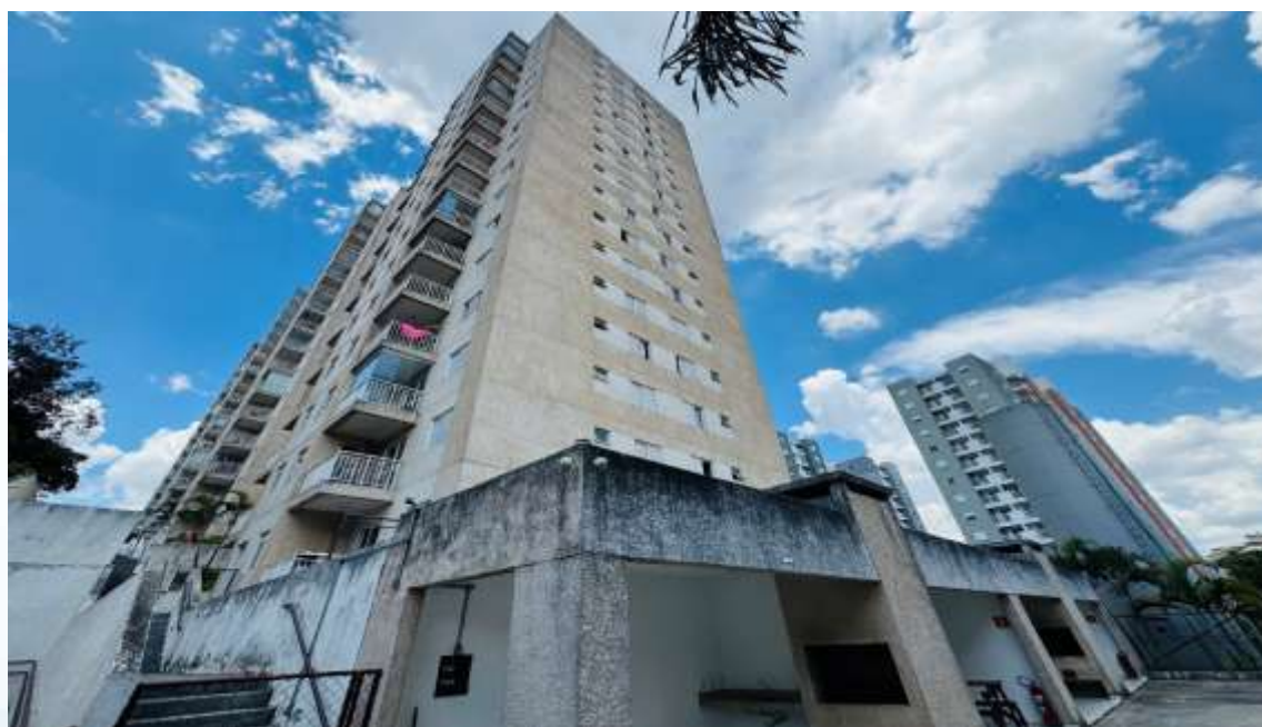
Área gourmet – área de lazer do condomínio (9)
