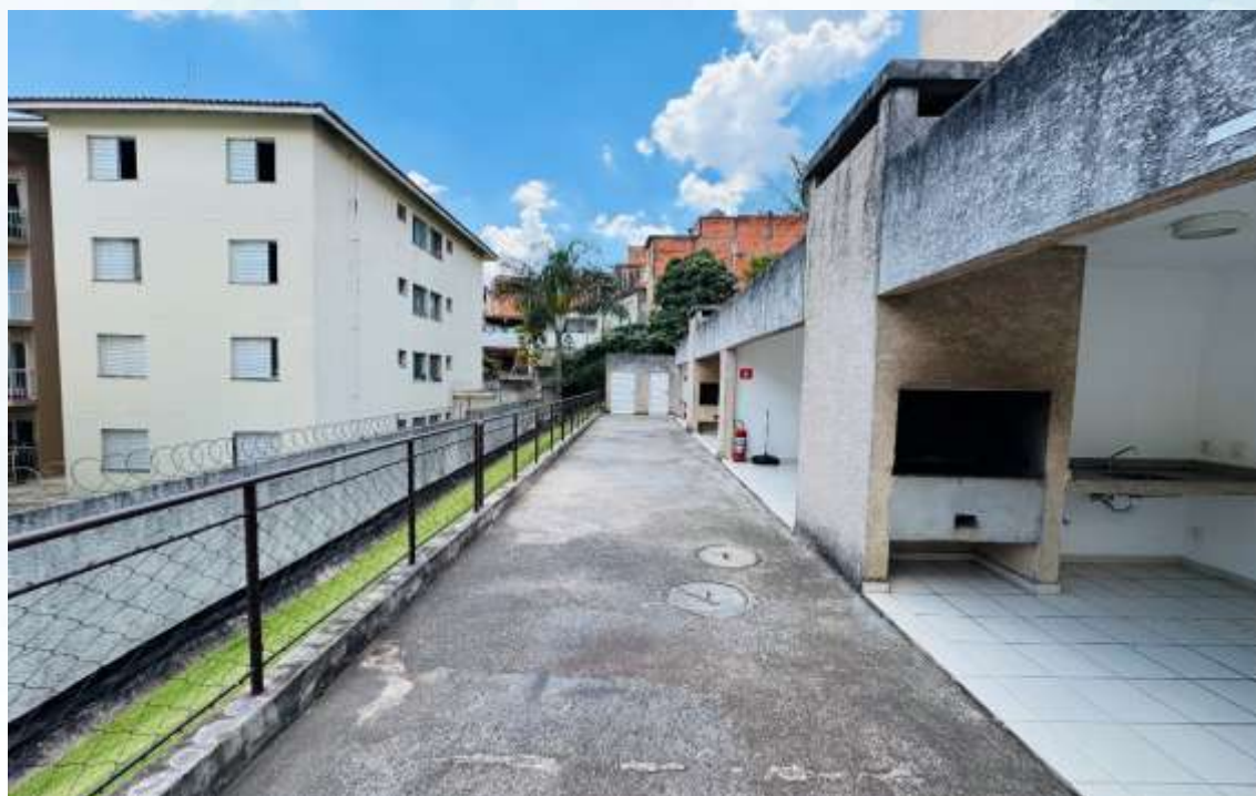
Área gourmet – área de lazer do condomínio (6)
