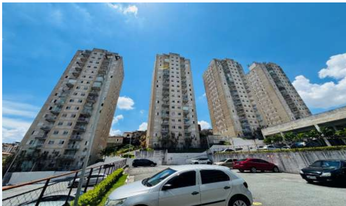
Estacionamento do condomínio (5)
