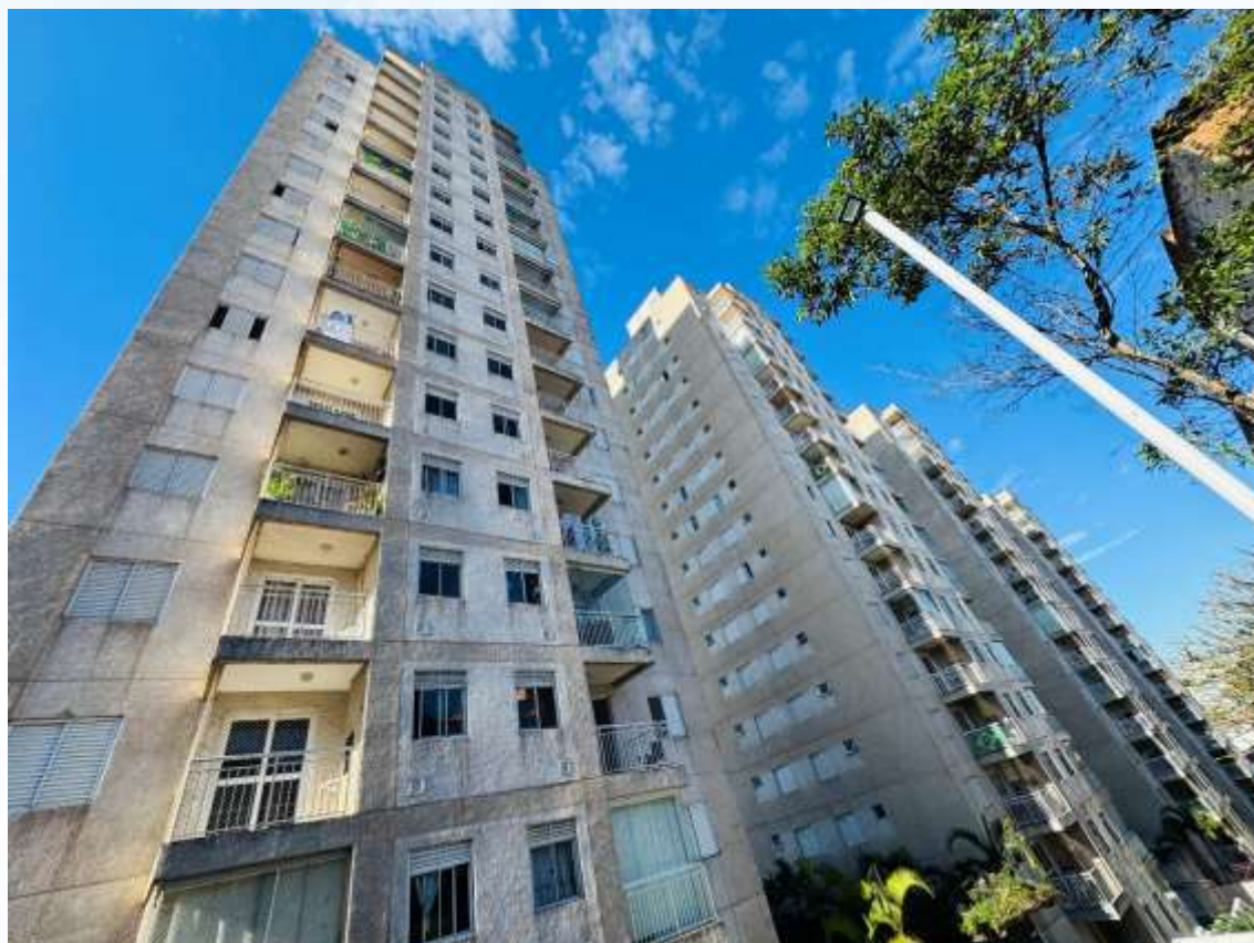
Fachada do imóvel – Quatro torres do Condomínio Europa
