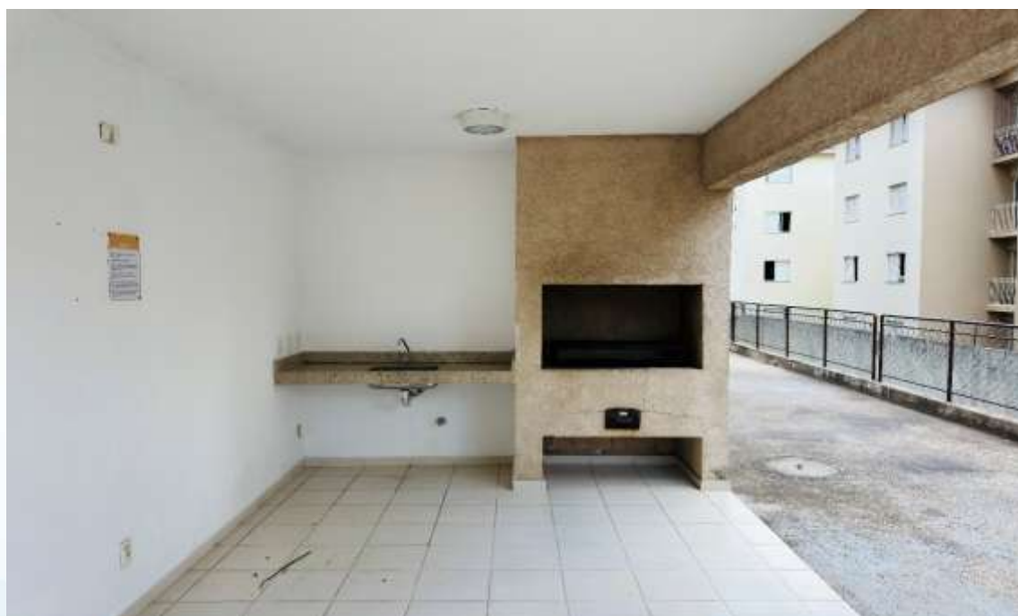
Área gourmet – área de lazer do condomínio (2)
