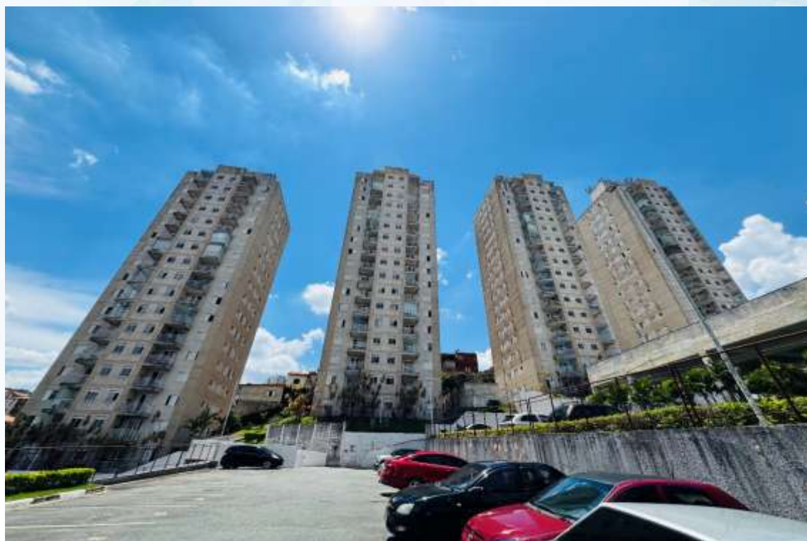
Estacionamento do condomínio (4)
