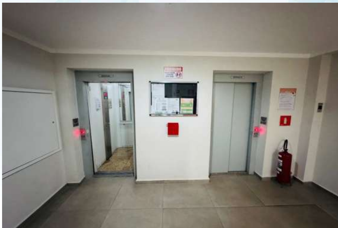
Hall de entrada da torre (1)
