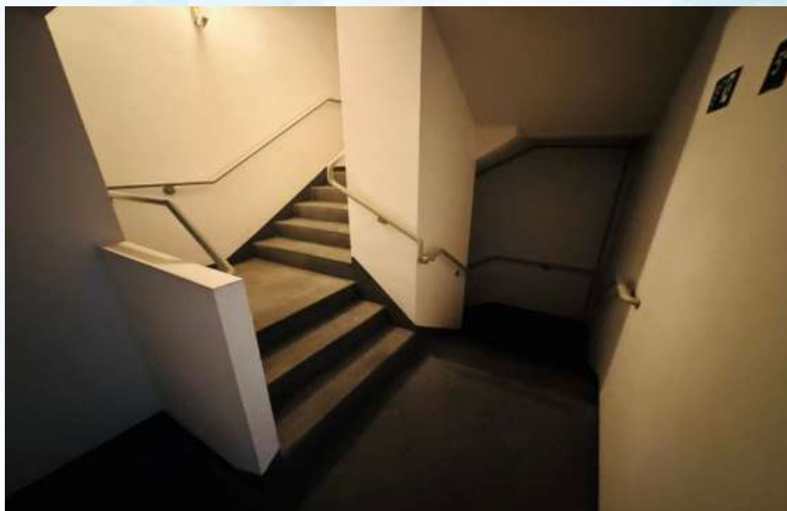
Escada de incêndio entre os apartamentos da unidade vistoriada
