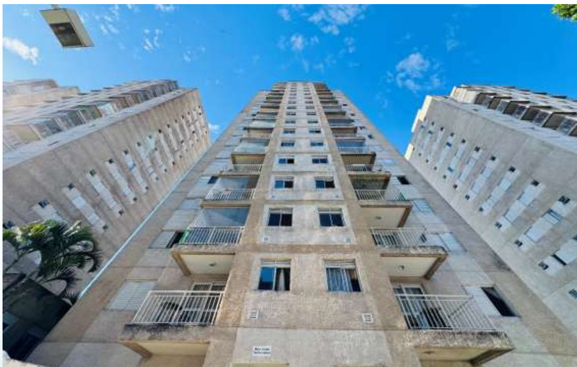
Fachada da torre 3 – Lisboa (1)
