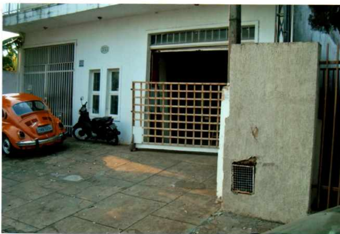
Vista da fachada da construção objeto da presente avaliação, com dois pavimentos, sendo o térreo do tipo salão comercial/industrial e o pavimento superior residência do tipo unifamiliar.
