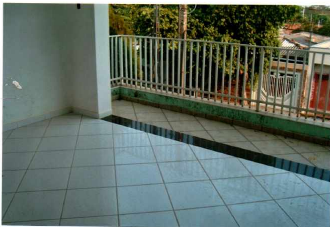
Vista parcial da sacada existente no pavimento superior (residência), com vista para a Rua Renato Werneck.
