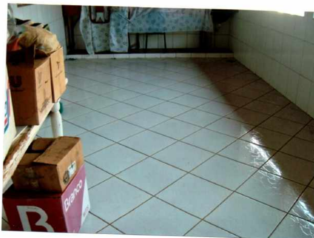
Vista parcial do interior da varanda existente no pavimento superior, parte dos fundos da residencia.
