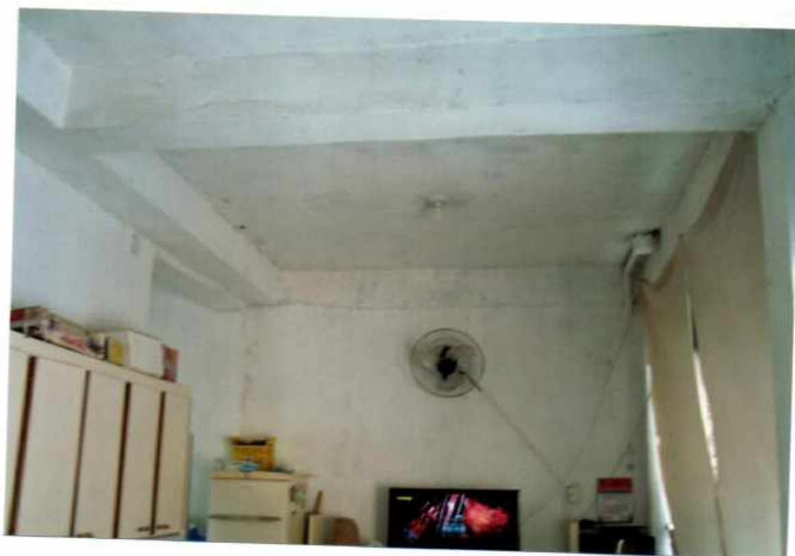
Vista parcial do forro do pavimento térreo, com laje e vigas de concreto bem estruturado.
