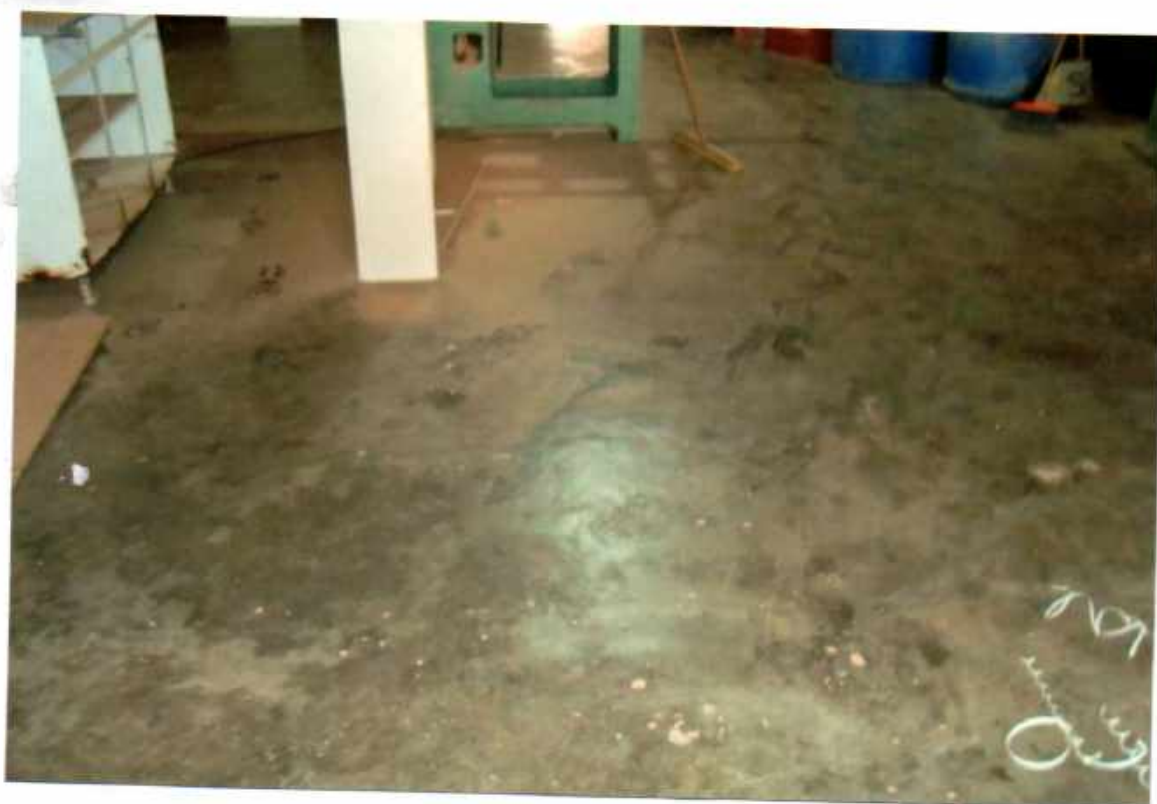
Vista parcial do pavimento térreo com piso em cimento estruturado liso e escada de acesso ao pavimento superior destinado à residência.
