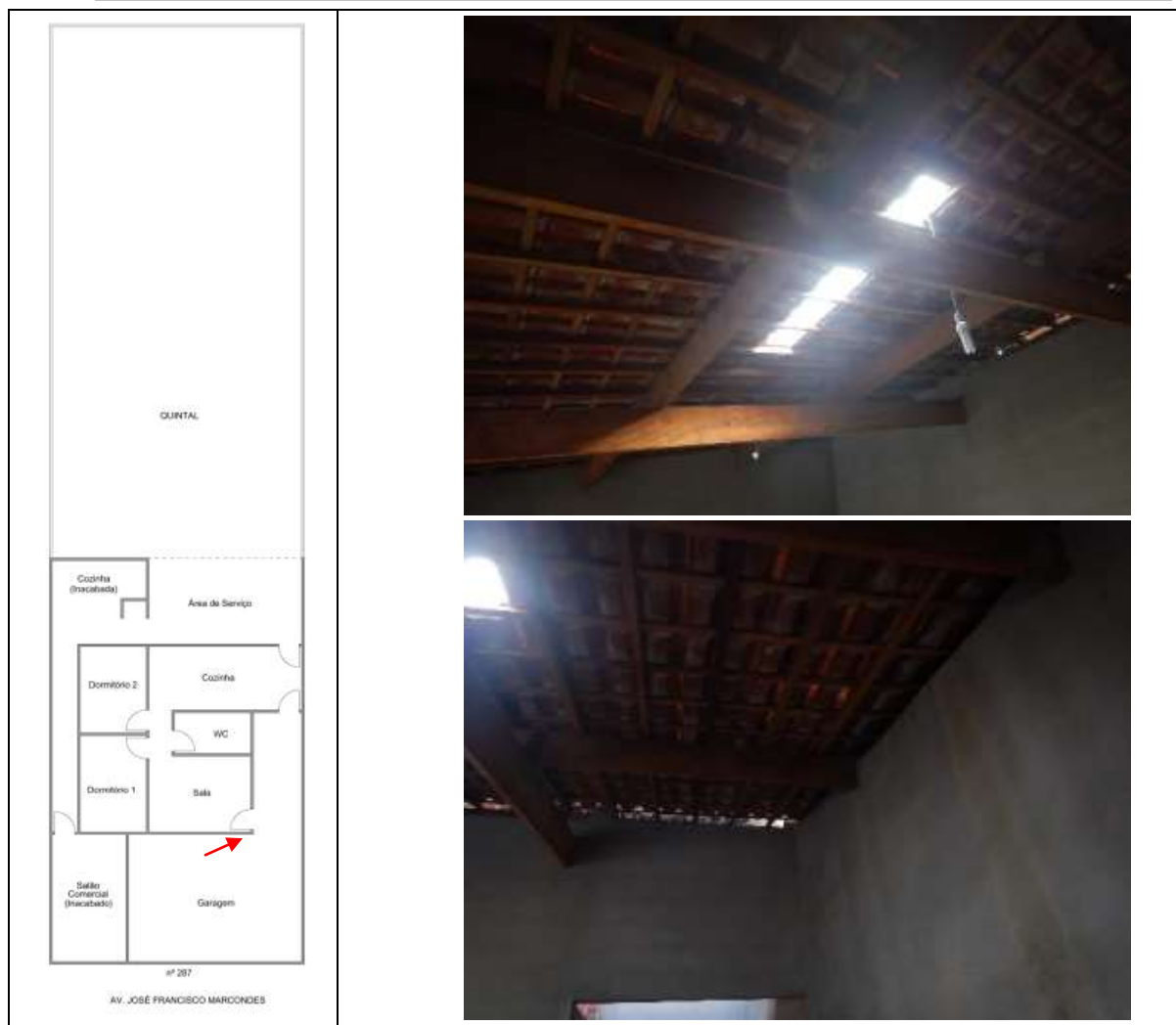
VISTAS DA ESTRUTURA DA COBERTURA DA GARAGEM.
