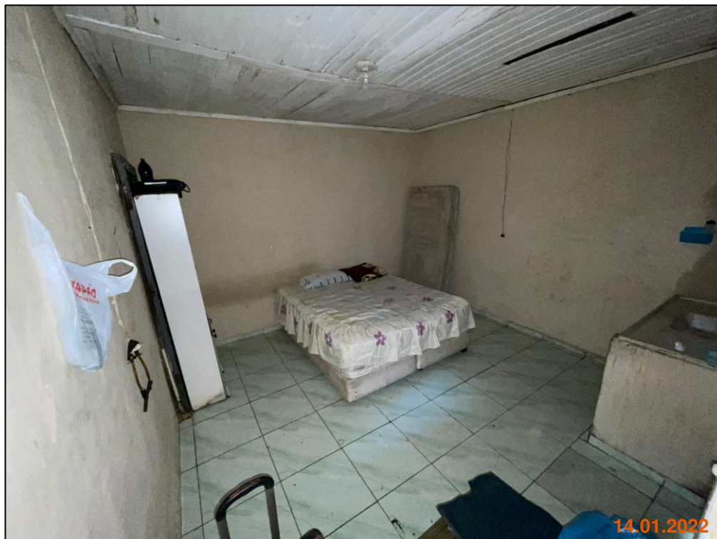
Foto 22: Vista geral do Dormitório 1
