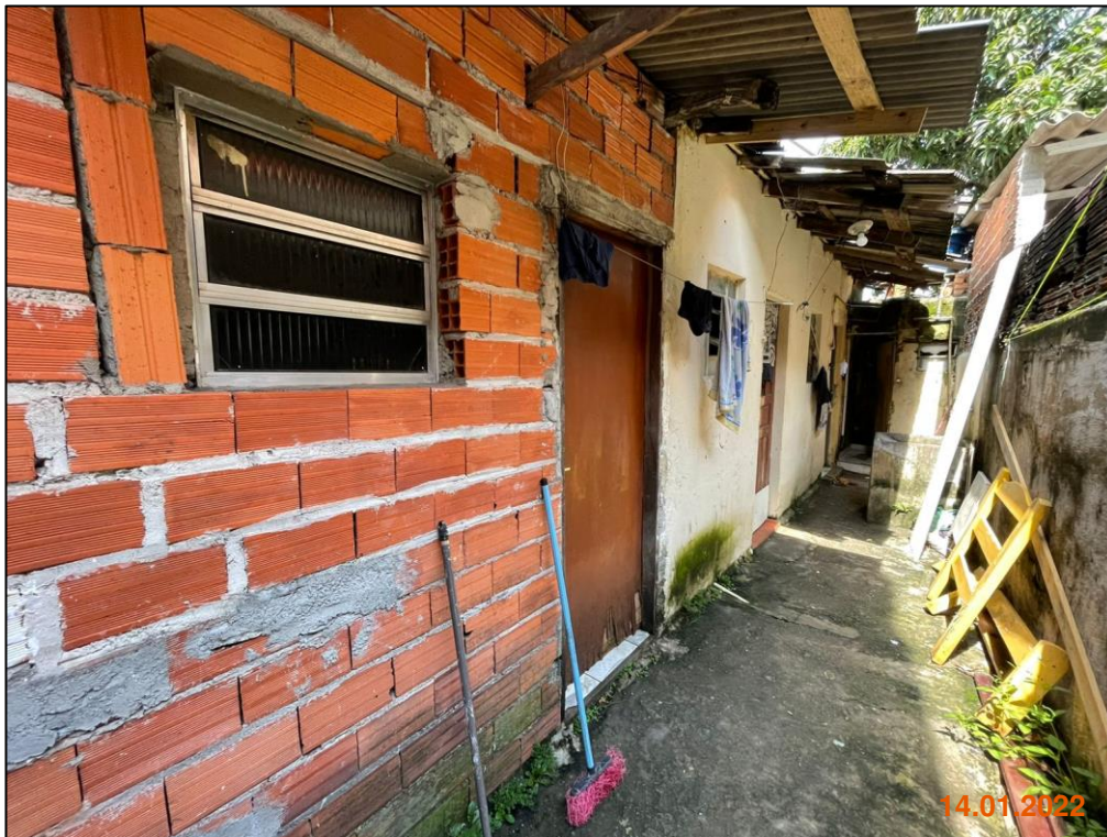
Foto 19: Vista geral do corredor lateral de acesso
