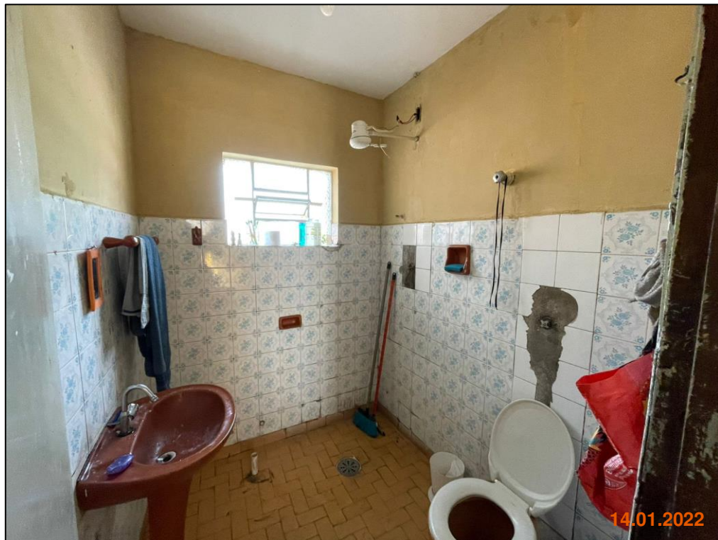
Foto 9: Banheiro da casa 1
