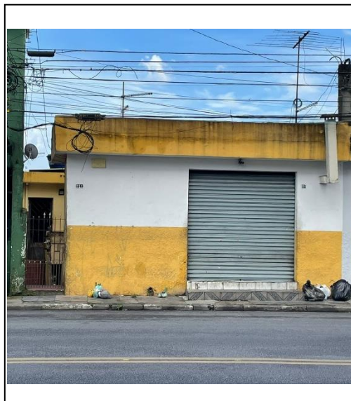
Imagem 1: Vista da fachada do imóvel
